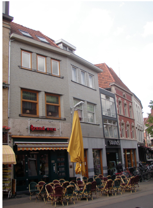
Afb. 2.3 Voor- en achterzijde van het pand Parade 68. Op de linker foto zijn de twee grijze gevels nr. 68ab en 68cd. De poort naar het achterterrein van nr. 68 bevond zich ter plaatse van de zwarte gevel met de winkelnaam 'SOUNDS'.
